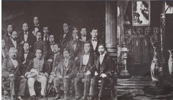
2000年佐賀縣立美術館出版的《納富介次郎與四大工藝流派：明治時期設計的先驅》，介紹明治時期設計先驅者納富介次郎陸續創立石川縣工業學校（1887）、富山縣立工藝學校（1894）、香川縣立工藝學校（1898）、佐賀縣立有田工業學校（1901）四所工藝與工業相關學校，大力推廣西洋工藝的圖案方法用以改善日本傳統工藝，提昇外銷貿易的競爭力。（圖版提供：林懿馨）
